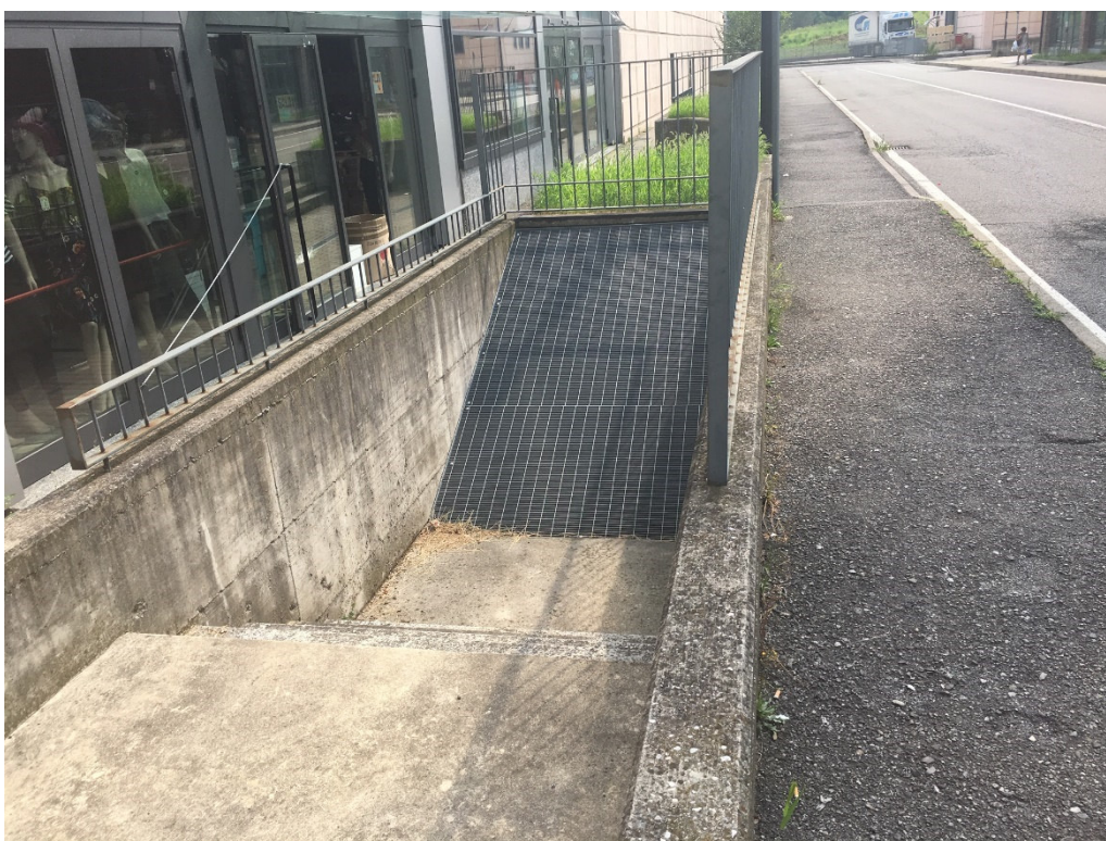
Foto n 7 – Accesso parcheggio interrato
