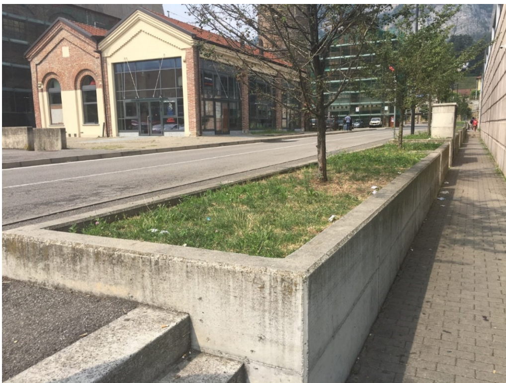
Foto n. 12 – Primo tratto di via Fabbricone
