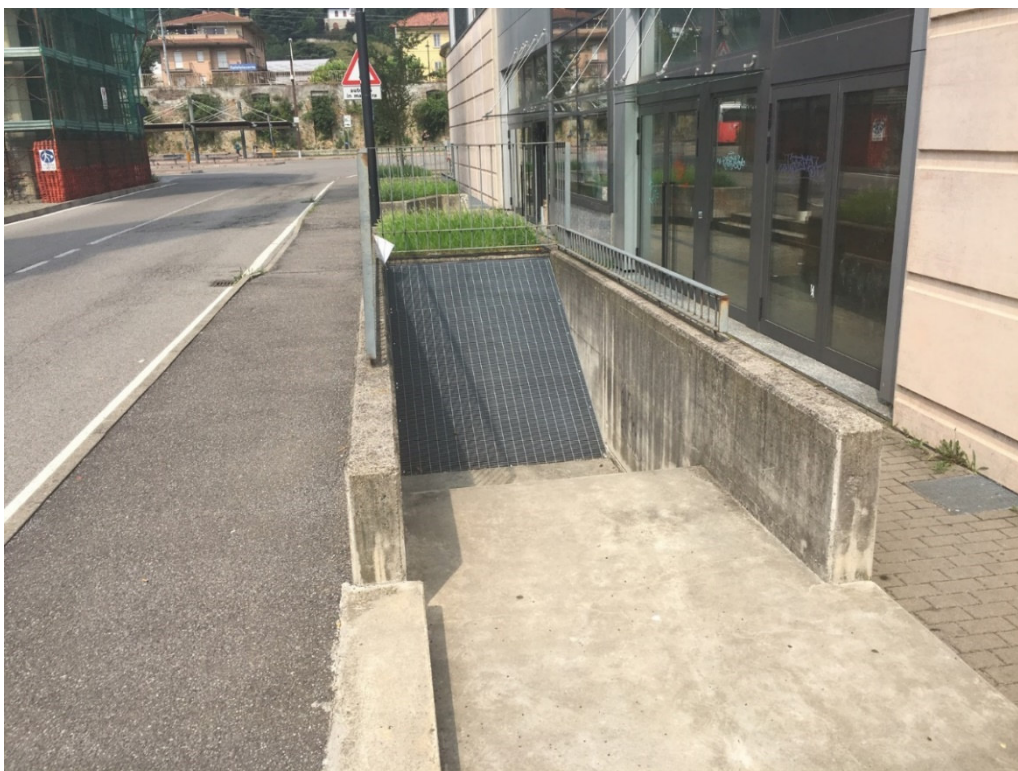
Foto n. 6 – Accesso parcheggio interrato
