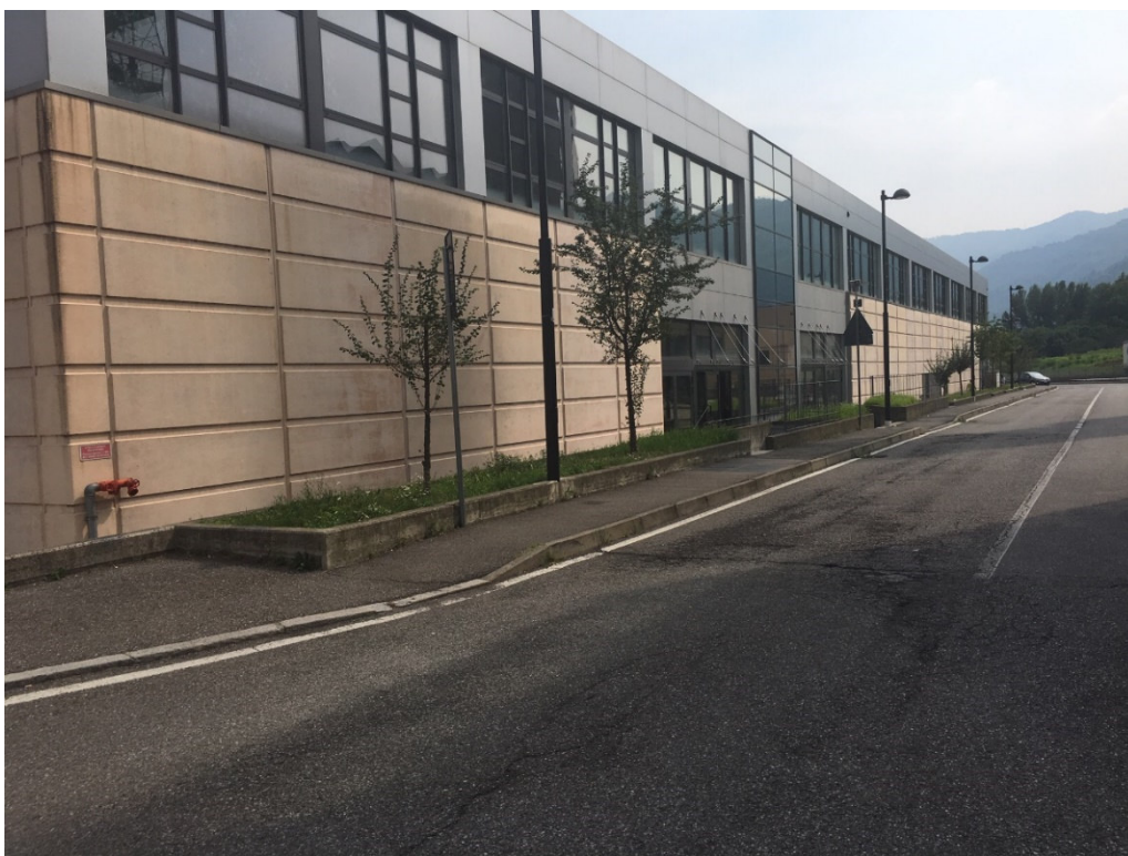
Foto n. 11 – Primo tratto di via Fabbricone
