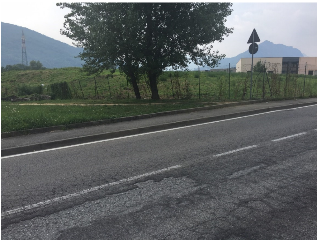
Foto n. 16 – Zona di attraversamento stradale della pista
