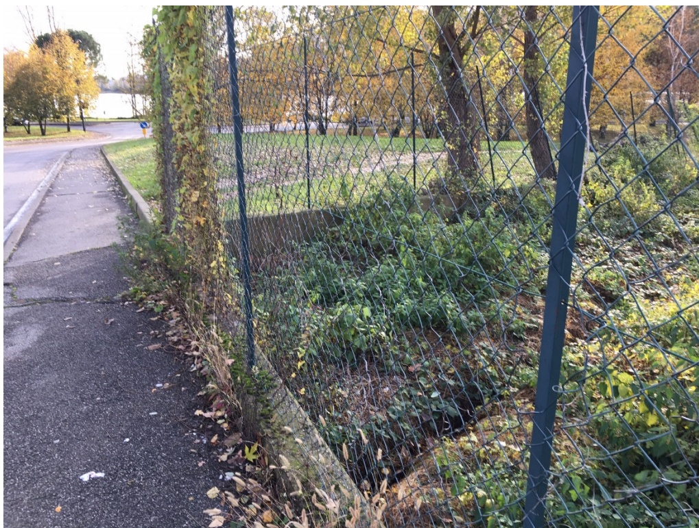
Foto n. 19 – zona di occupazione parziale
