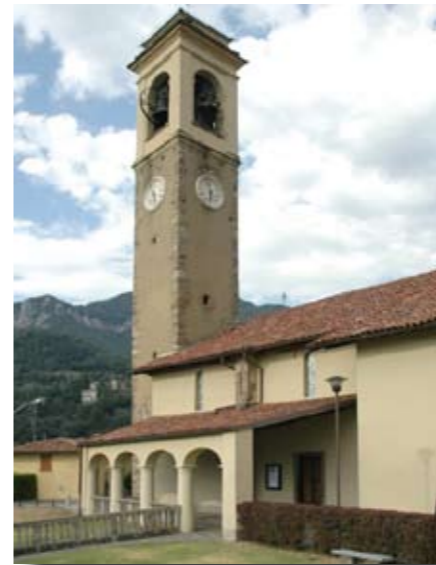
Campanile - Chiesa di Santa Brigida
